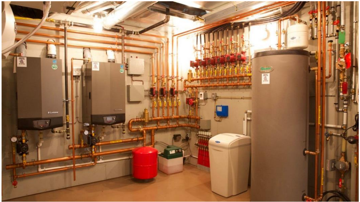
1.3 – сурет – Қазандықты және жинақтау цистернасы
